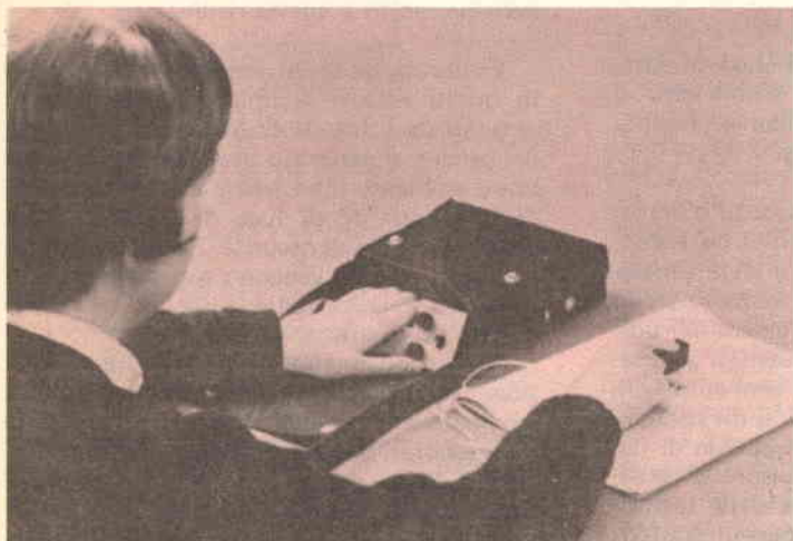
Fig. 5 - Apparecchio di lettura per ciechi: viene usato esplorando le lettere mediante un sensore tenuto nella mano destra, e tenendo contemporaneamente la sinistra su un trasduttore tattile.
